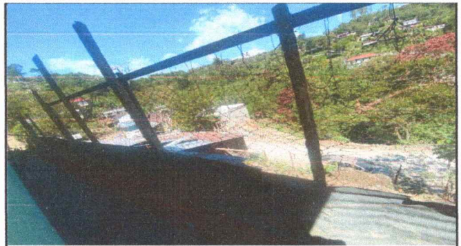
Foto 2: sustitucion de porton de malla por porton de metal
