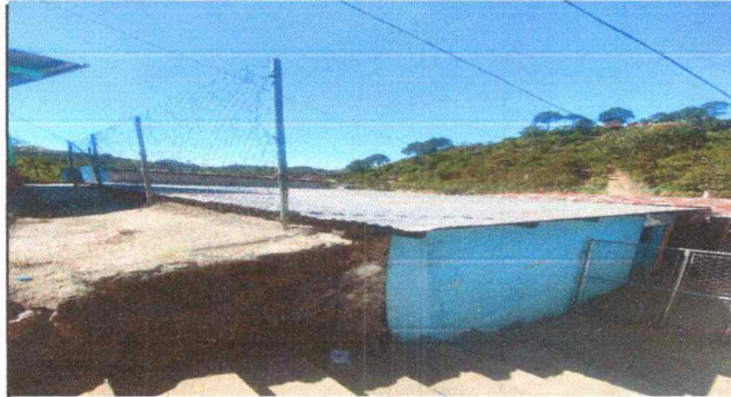
Foto 1: cubierta de lamina, sustitucion de laminas por laminas troqueladas
